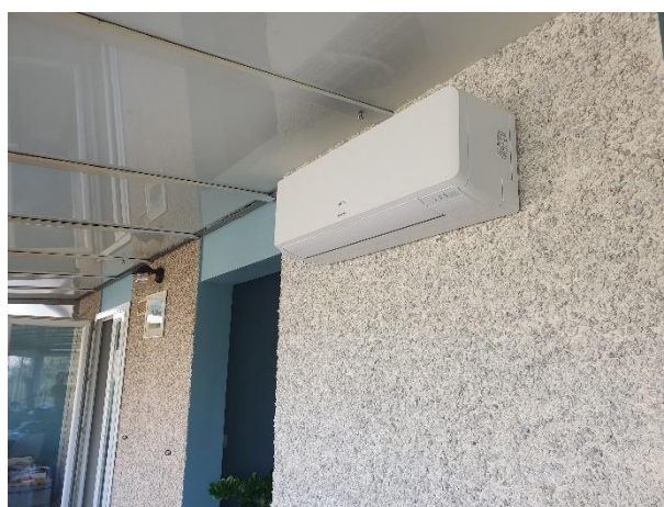
Figure 25 : Split installé dans une véranda de l'échantillon
